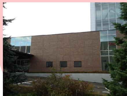
⑦取付完了（S造対応）
