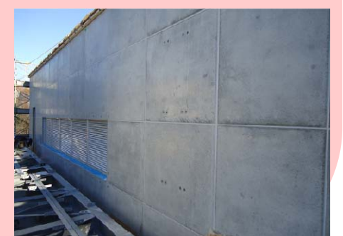
⑨取付完了（RC造対応）塗装下地
