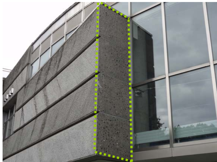
マトリックス割肌仕上げ+研磨仕上げ（ダイヤモンドカット仕上げ）を施工。
