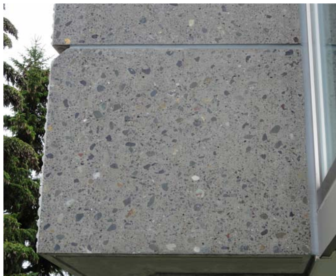
施工後、25年以上経過も凍結融解作用などの影響もなく、コンクリートは健全な状態で維持されています。
