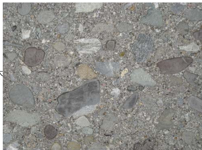
施工後、25年以上経過も凍結融解作用などの影響もなく、コンクリートは健全な状態で維持されています。
